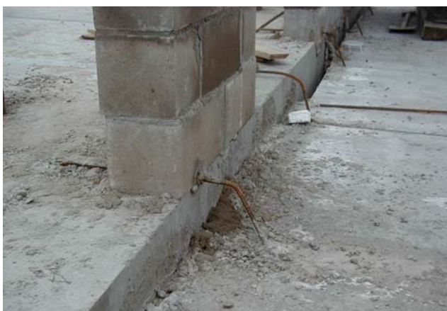
5.2. foto Nepareizi noenkurots starpstāvu pārsegums. (enkura stienis var izstiepties)
