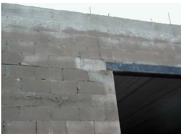
5.1. foto Nepareizs pārsedzes atbalsta garums (atbalsts pārāk īss)
